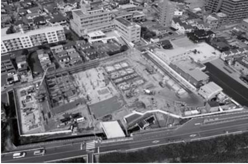
工事現場航空写真（7月末）
