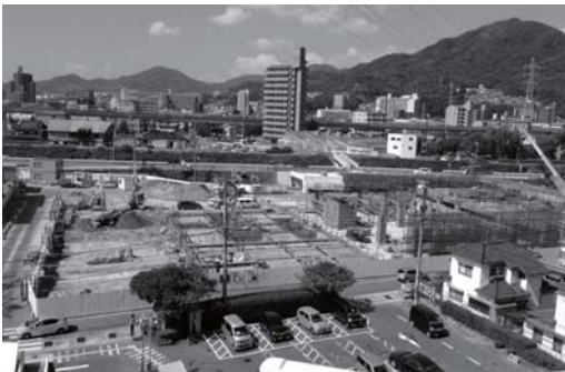
工事現場写真（8月20日）
