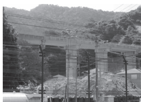
広島呉道路高架下に運び出された流出した土砂（小屋浦）
