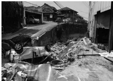
土砂でアスファルトが剥がされた道路
