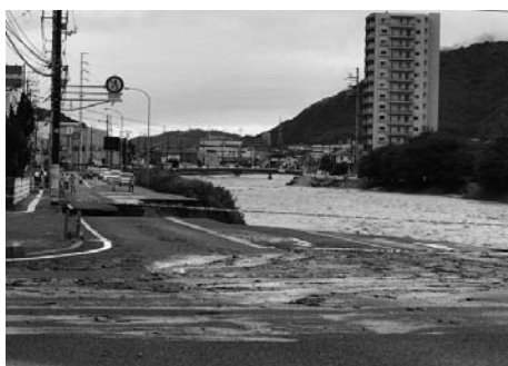
陥没した国道2号線（広島市安芸区瀬野川）
