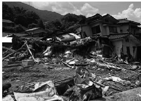
被災された住宅
