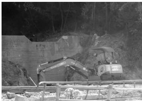
土石流が砂防ダムを乗り越えて線路に押し寄せた。(小屋浦付近)
