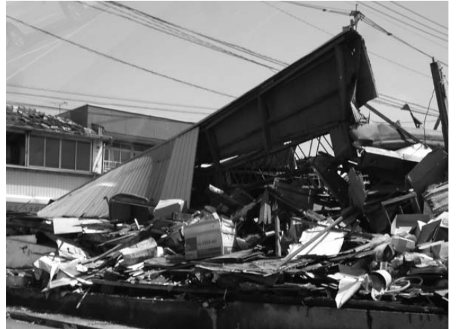
益城町内の被害状況
